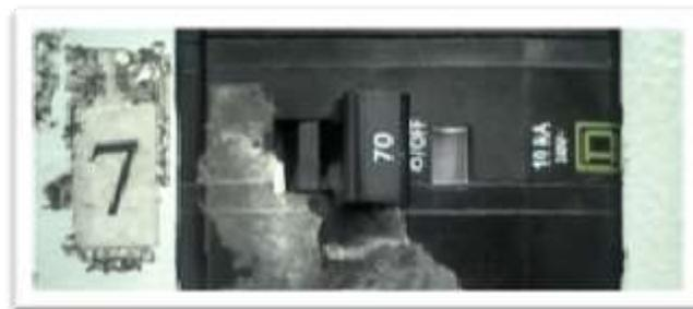
Figura. 41 Colocación del interruptor en off.
