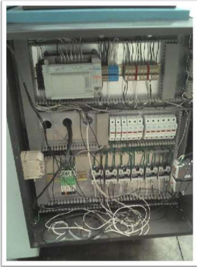
**Conexión de control manual a Allen Bradley Micrologix 1500.**
