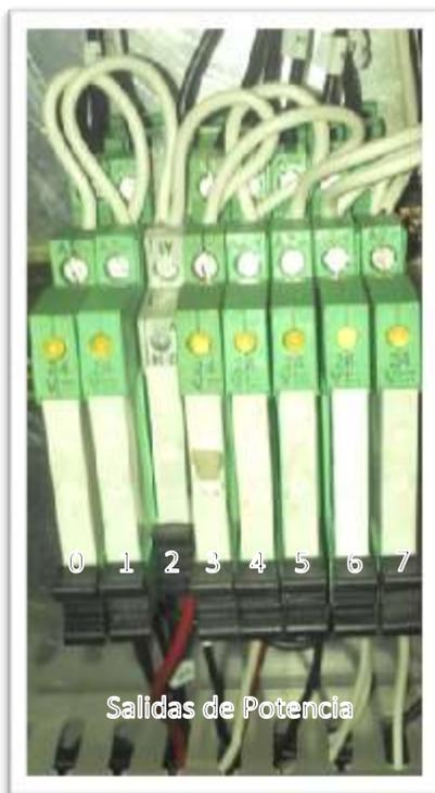
Figura. 52 Salidas del PLC a 24 vdc.
