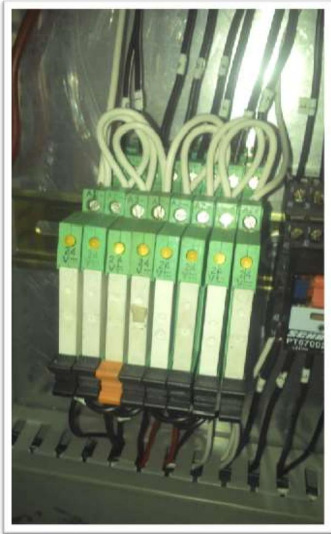
**Colocación de protección a PLC, utilizando autoacopladores.**
